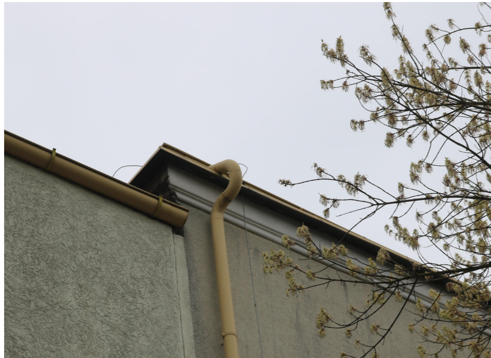
FOTOGRAFIA OBRAZUJE AKTUALNY GZYMS KORONUJĄCY STAREJ CZĘŚCI BUDYNKU DYDAKTYCZNEGO. PLANOWANE ROBOTY BUDOWLANE NIE BĘDĄ NARUSZAŁY ISTNIEJĄCEGO GZYMSU.
